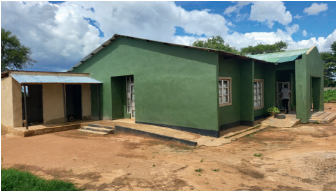
Unser Wohnheim mit den neuen Waschräumen
